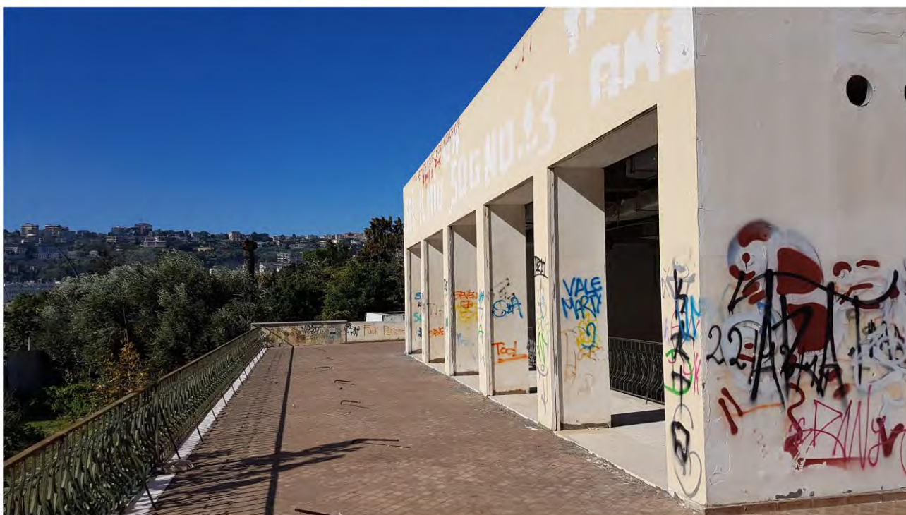
Foto 07 Il Terrazzo fronte Sud a quota primo piano
