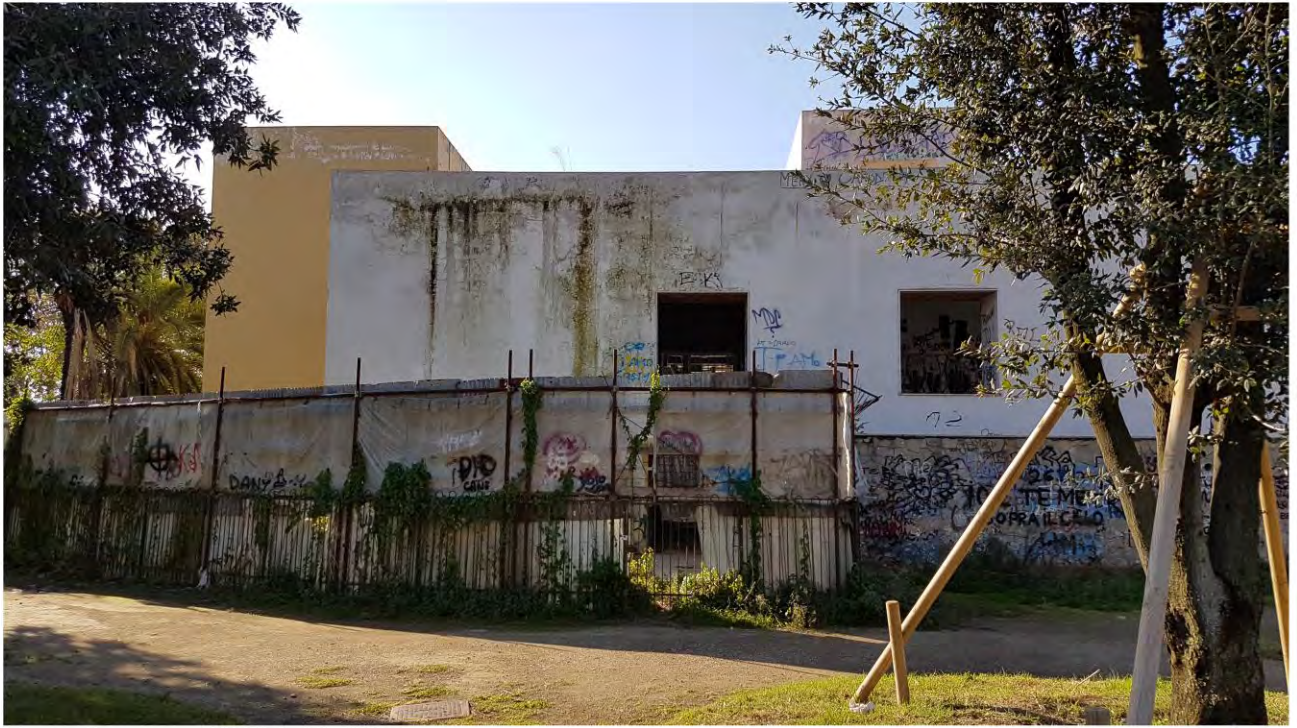
Foto 02 Fronte Nord Ingresso interno alla Villa Comunale
