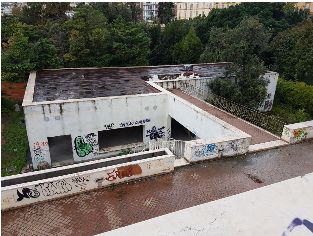
Foto 11 La Copertura del Corpo di ampliamento Pranzo e Cucina
