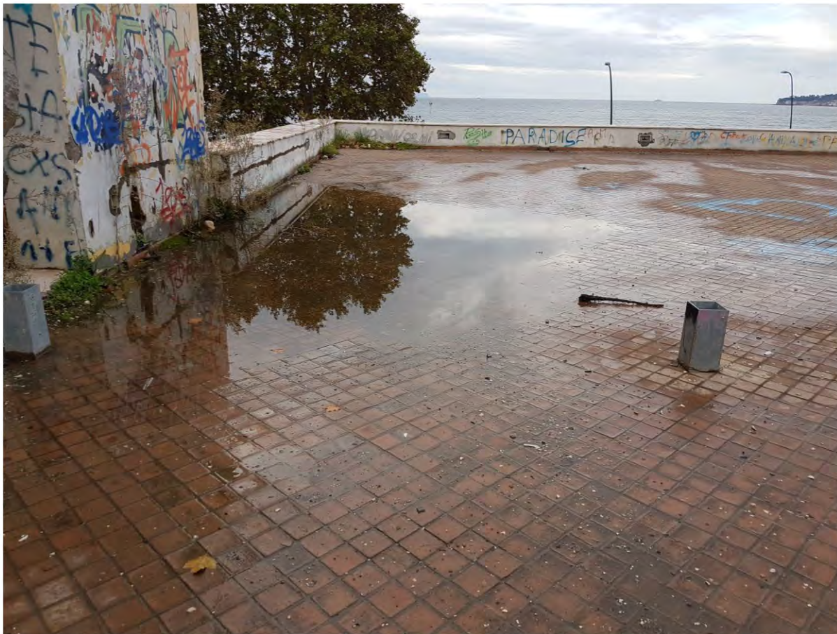
Foto 10 Il Terrazzo a quota Coperture
