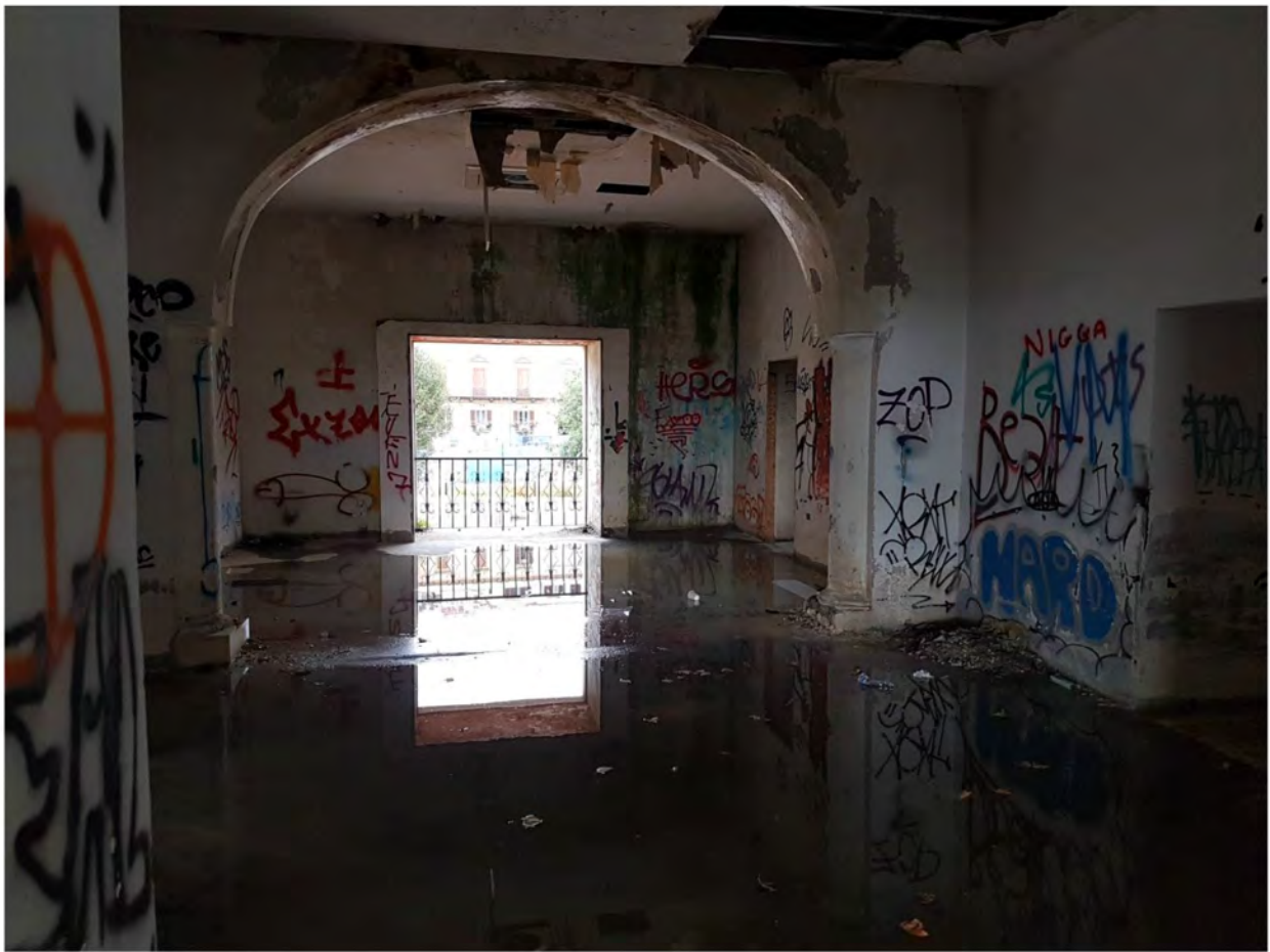
Foto 18 La Sala centrale a quota primo piano
