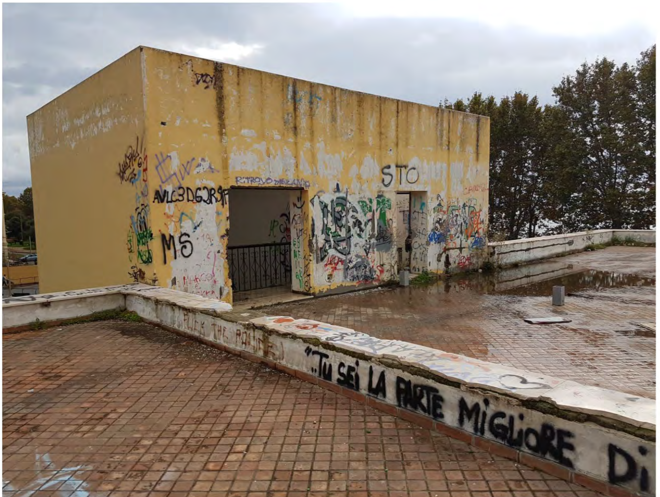
Foto 12 Il Terrazzo a quota Coperture a doppia quota sfalsata. Il Volume emergente della scala interna e vano impianti
